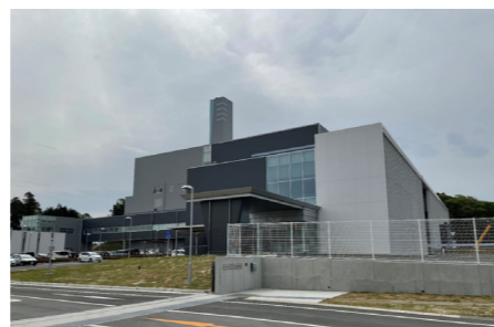
クリーンの森合志（ごみ焼却施設）
