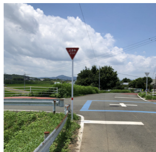
交差点に止まれの標識を設置
